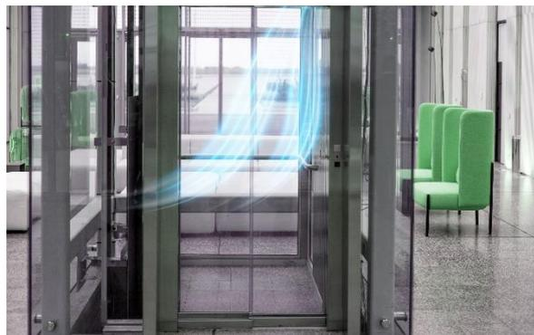
Bei der Entwicklung der LIVE AIR Lösungen wurde der Fokus unter anderem auf die Thematik Ozon gelegt. Die LIVE AIR Geräte erzeugen bei bestimmungsgemäßer Verwendung weniger als 20 ppb in einer Aufzugskabine und sind somit weit von gesetzlichen Richtwerten (60ppb) entfernt. Dies ist auch genau der Schwellwert, bei dem die menschliche Nase Ozon detektiert.
